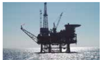
Plataforma Casablanca (Tarragona)
