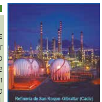
Refinería de San Roque-Gibraltar (Cádiz)
